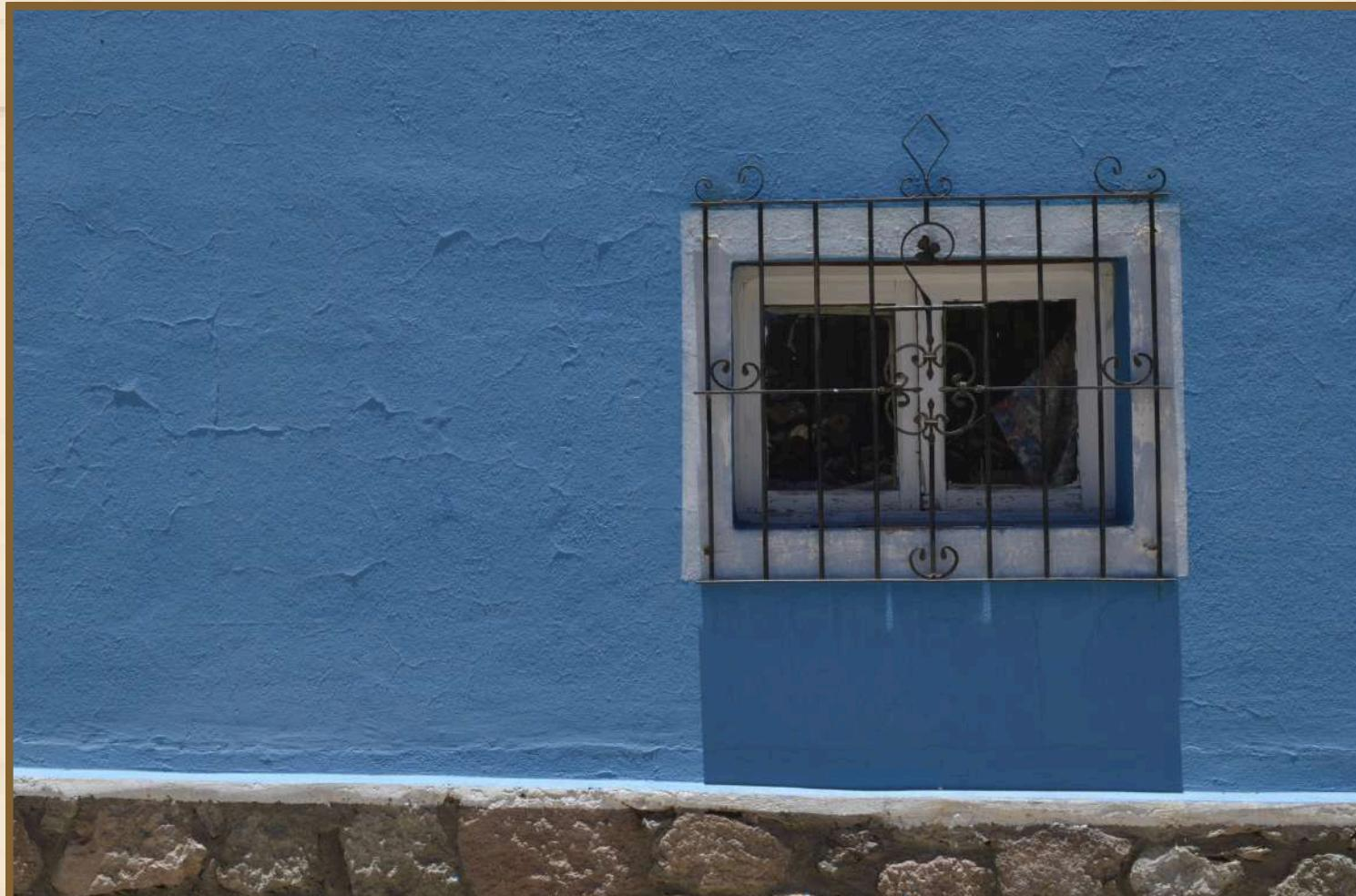
Al pie de los muros se identifica un zócalo y una vereda de piedra local, imprescindibles en una época en la que las lluvias eran más abundantes y frecuentes. En su interior, se aprecia el techo original con vigas de madera que sostienen un entramado de caña y una capa de cortaderas recubierta de torta de barro para mayor protección contra las inclemencias del clima.
